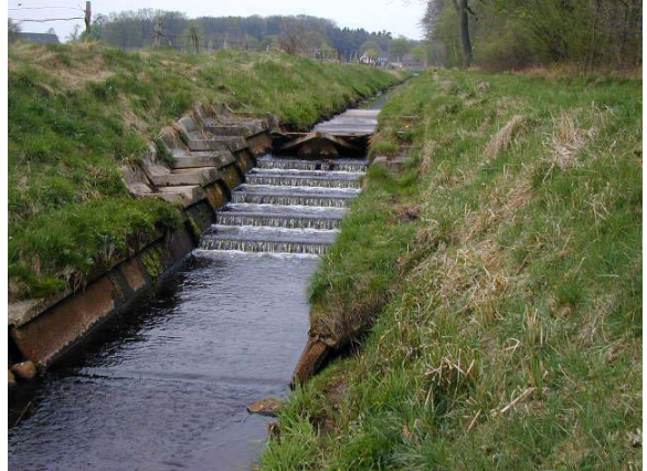
Kuhbach (Oberlauf): Strukturgüteklasse 7 (vollständig veränderte Gewässerabschnitte)
